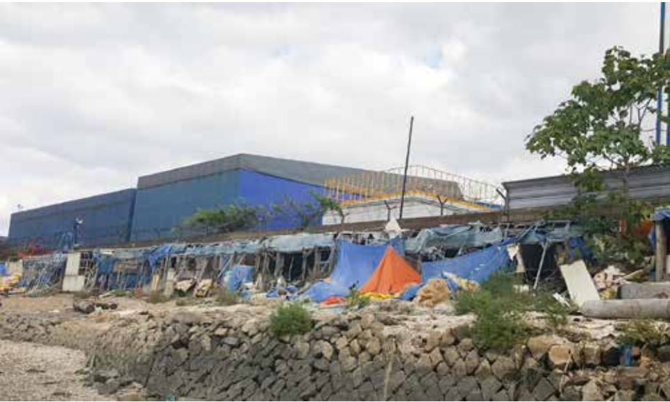
〈사진 11〉 철거 직전 굴막 전경 (출처: 구술자 기증)
